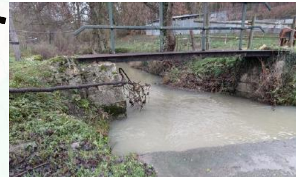
Remplacement de l'ouvrage
