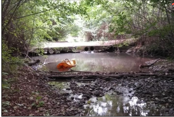
Ouvrage de franchissement Amont de la RD976
