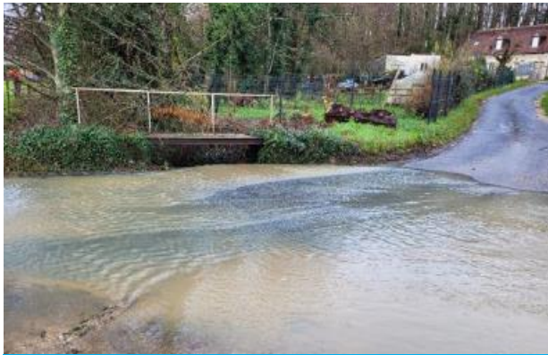
Remplacement de l'ouvrage
