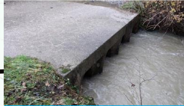
Remplacement de l'ouvrage
