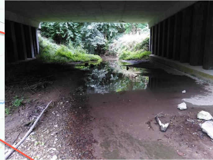
Radier du pont de la RD976 En appui au Département
