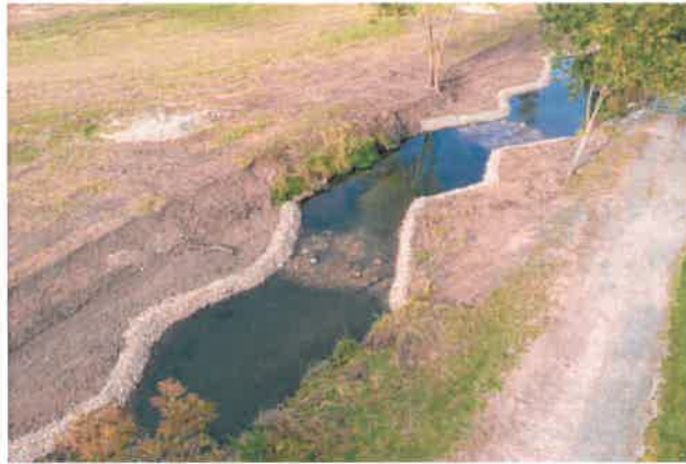
Exemple de tronçon restauré à la Gloriette
